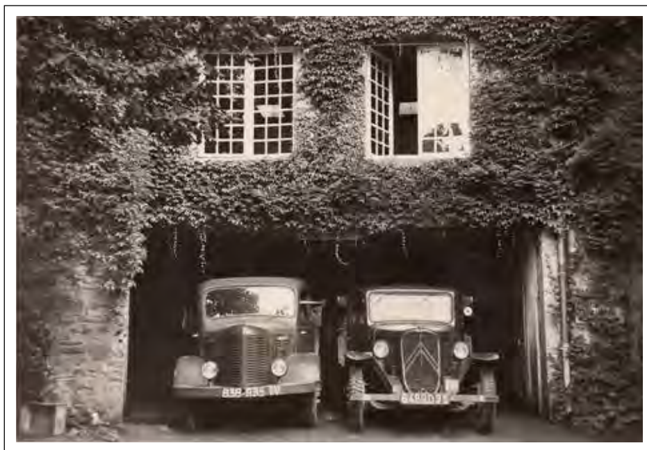
À gauche l'Hotchkiss, à droite un U 25 Citroën appartenant à un collecteur indépendant. Au-dessus, les deux fenêtres de la cuisine-réfectoire du personnel. © Photo studio François Nicolas
