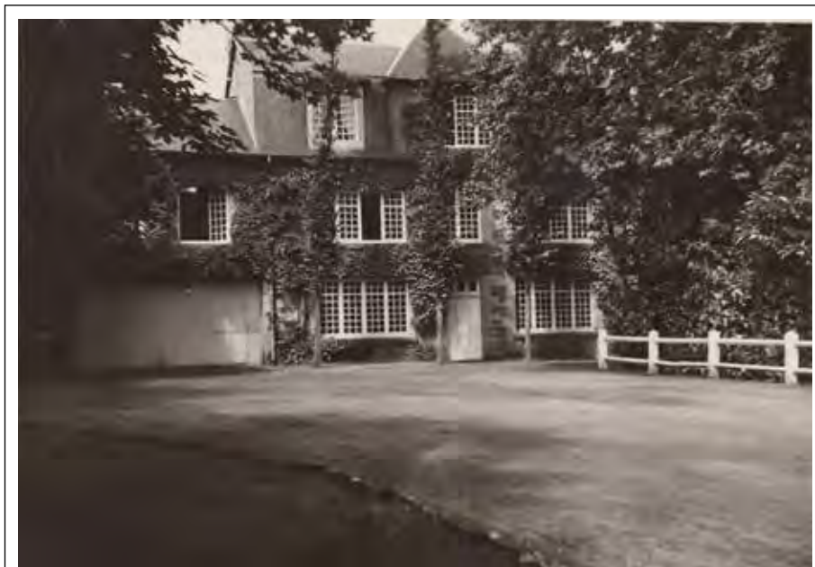
De gauche à droite : porte fermée du quai de réception du lait, fenêtre du bureau d'accueil, porte d'entrée, fenêtre du laboratoire. À l'étage, fenêtre du logement privé de la famille Nazart. © Photo studio François Nicolas
