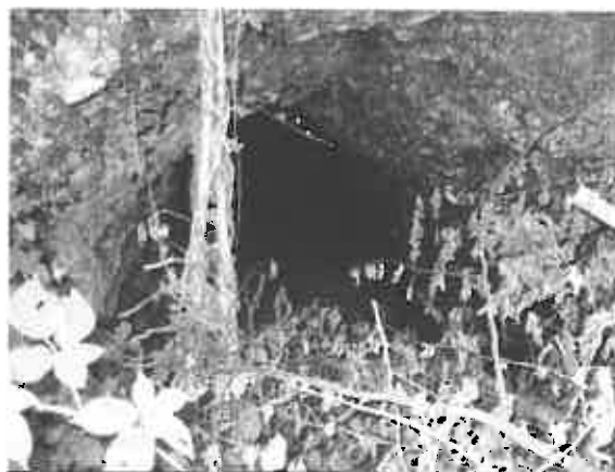
Photos 3 et 4 : Galerie du Lieu-dit « La Grangèle »
