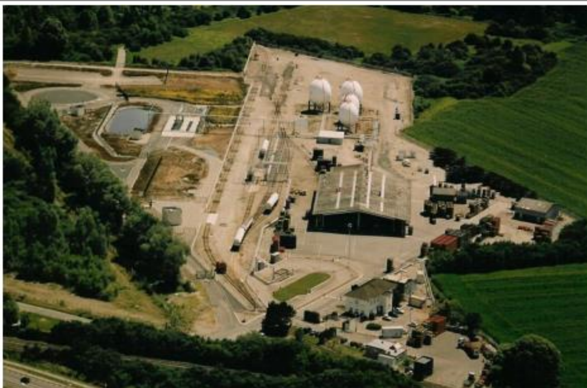
Vue sur le site emplisseur
