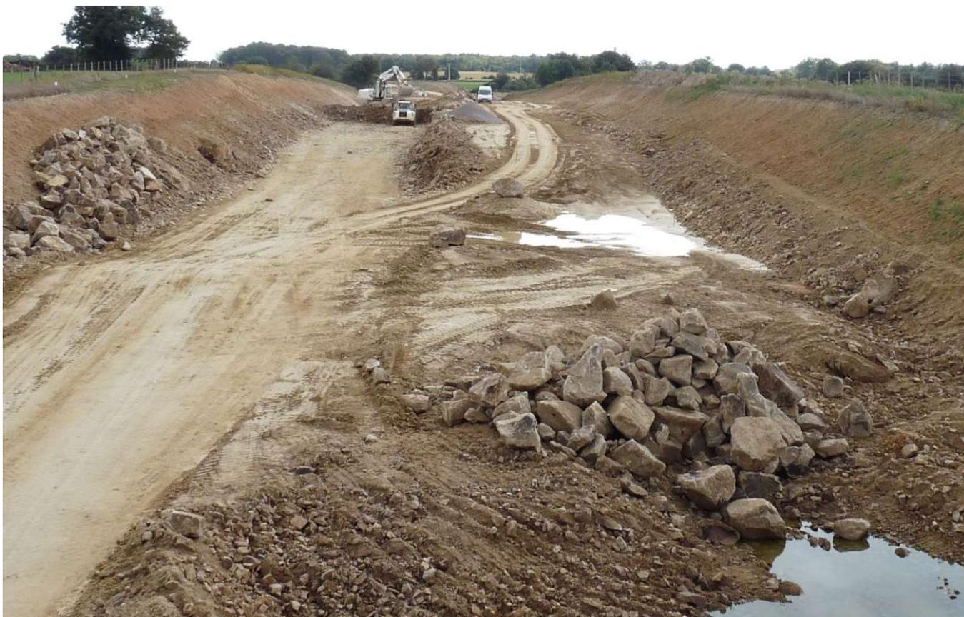
Cette photo montre qu'après une pluie récente, le terrassement en pleine masse a pu reprendre dans cette partie, alors que la teneur en eau des sols ne permettait pas de relancer la mise en œuvre de la couche de forme à quelques centaines de mètres de là. (Au titre du même marché)
