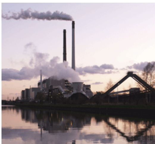
Une centrale électrique à charbon en Allemagne (source wikipedia)
